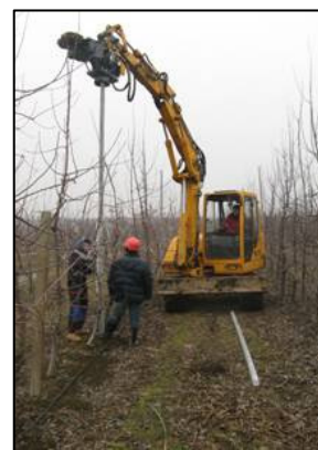
Postavljanje stubova kao noseće konstrukcije za protivgradnu mrežu u starim zasadima jabuke utiskivanjem posebnom mašinom (foto: D. Radivojević).
