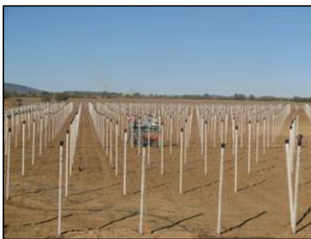
Postavljanje infrastrukture za protivgradnu mrežu, koja istovremeno drži sadnice jabuke u upravnom položaju, najbolje je uraditi pre sadnje (foto: D. Radivojević).
