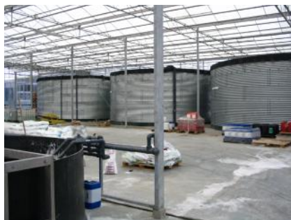
Tankovi za vodu i hranu u stakleniku (foto: Đ. Moravčević)
