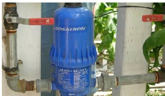
Uređaj za fertigaciju (foto: Đ. Moravčević)
